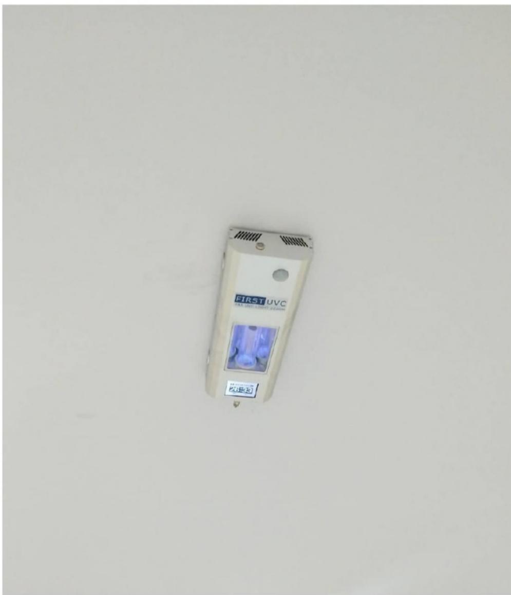
รูปที่ 3 ติดตั้งคอมไฟอีกไซเมอร์ UV-C ไว้บนเพดานใกล้ทางห้อง สูงจากพื้นห้อง 2.4 เมตร (เปิดปิดโดย Remote control)
